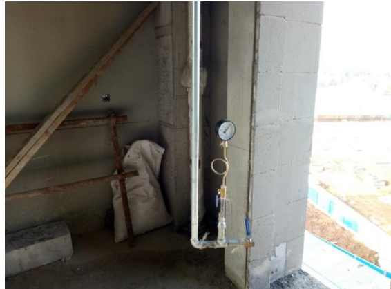
科教楼二5层喷淋试压 (2017. 3. 16)
