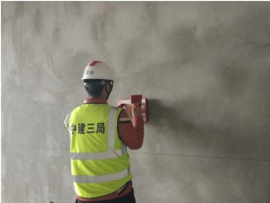
公教楼二抹灰实测数据上墙 (2017. 3. 15)
