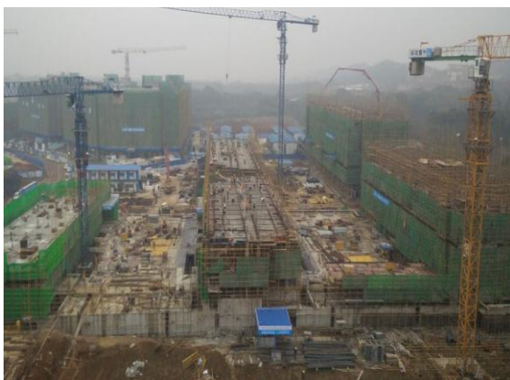
学生宿舍二组团施工全景 (2017. 3. 16)
