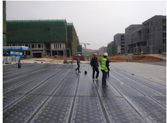
校前区地下室顶板防水卷材施工 (2017. 3. 16)
