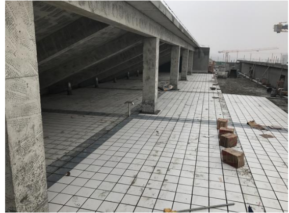
学生宿舍三组团 2#楼屋面防滑地砖铺设 (2017. 3. 18)
