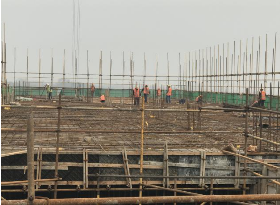
大学生活动中心 A 区二层竖向 三层水平梁板结构施工 (2017. 3. 18)
