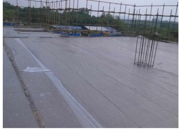
科教一混凝土浇筑 (2016.9.2)
