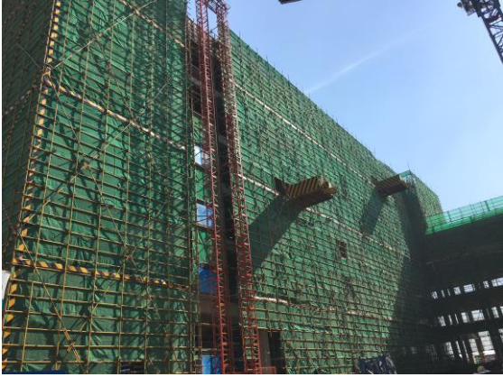
科教三物料提升机安装 (2016.9.2)
