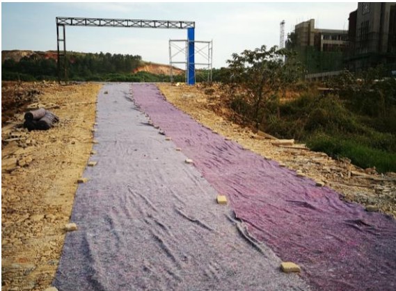
桥梁项目入口路面防扬尘措施 (2016.9.3)
