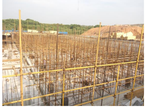
学生宿舍三组团 4#楼地下室满堂架搭设 (2016.9.4)
