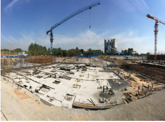
校前区施工全貌 (2016.9.4)
