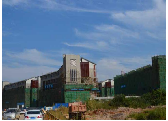
学生宿舍一组团外架拆除中 (2016.9.1)
