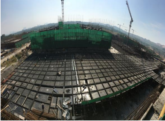
核心区地下室区域全貌 (2016.8.31)
