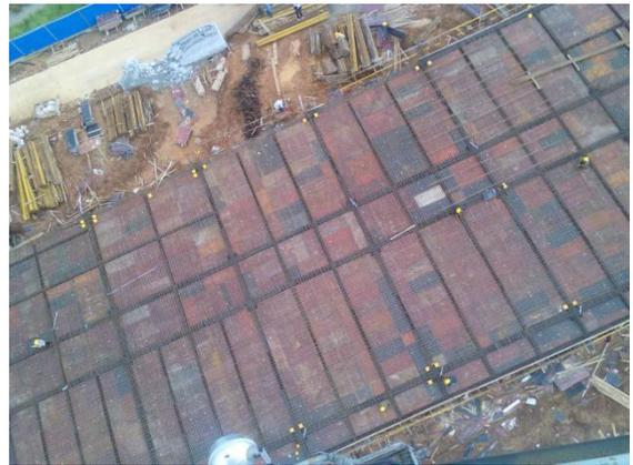
科教三架空层模板施工、钢筋绑扎
