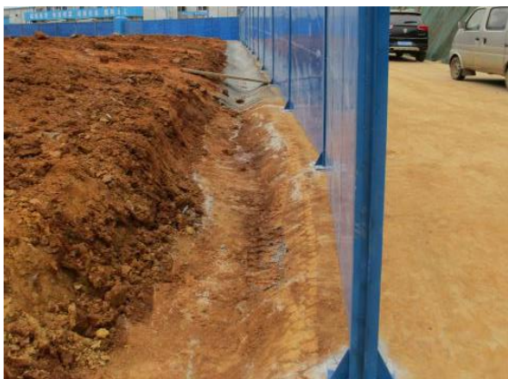
学生宿舍三组团西侧围挡安装及排水沟开挖。 (2016. 5. 4)
