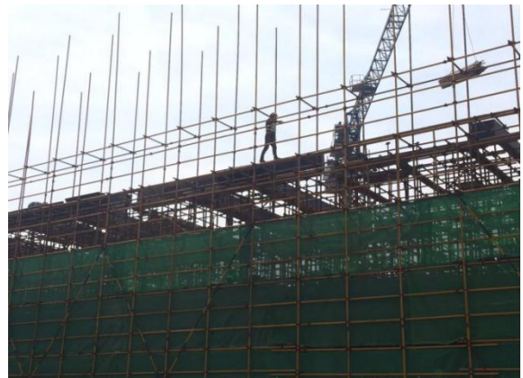
科教二北侧外脚手架搭设 (2016. 4. 29)
