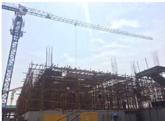
科教楼三一层模板架体施工 (2016. 4. 29)
