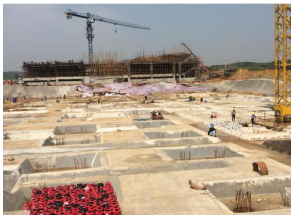
公教二人工清底、斜坡垫层施工 (2016. 4. 29)
