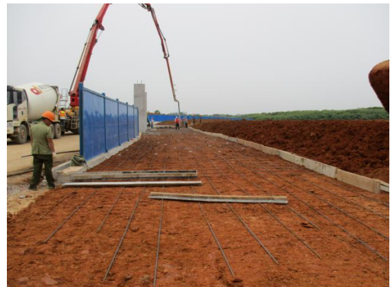
环一路侧主道路浇筑。 (2016. 5. 4)
