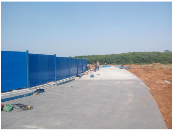
学生宿舍三组团北侧围挡安装。 (2016. 5. 3)
