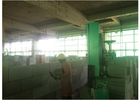
学生宿舍一组团 2#楼 2层 砌体施工 (2016. 5. 3)
