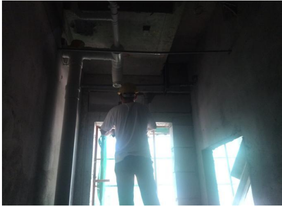
学生宿舍一组团 4#楼 1层 管道施工 (2016. 5. 3)
