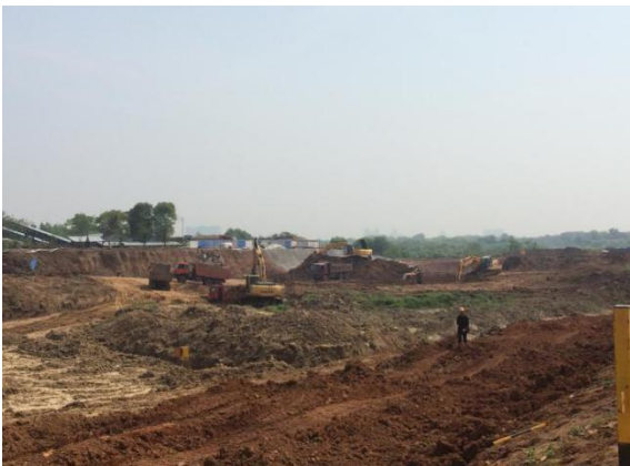
教学服务中心环路施工、清淤换填 (2016. 4. 29)
