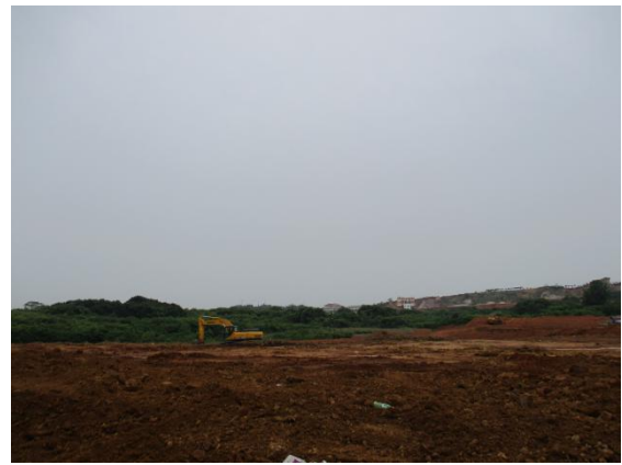
学生宿舍三组团东侧道路基础压实。 (2016. 5. 4)
