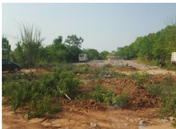
梨豹路上房屋拆除 (2016. 4. 30)
