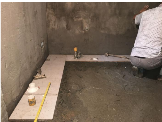
学生宿舍一组团 4#楼一层无障碍居室卫生间地砖铺贴 (2016. 5. 31)
