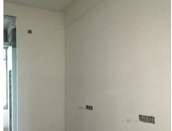
学生宿舍一组团室内腻子施工第一遍（134#楼已至 4 层） (2016. 5. 31)
