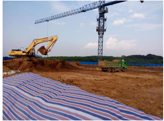
学生宿舍三组团 2#宿舍楼基础开挖。 (2016. 5. 31)
