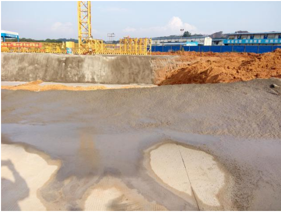
学生宿舍三组团 1#宿舍楼基坑喷锚。 (2016. 5. 31)
