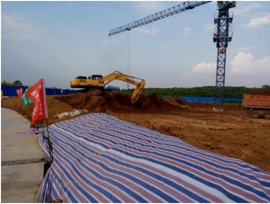
学生宿舍三组团 2#塔吊安装。 (2016. 5. 31)
