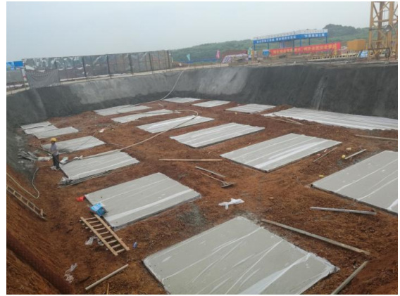
学生宿舍三组团 1#宿舍楼基础垫层浇筑。 (2016. 5. 31)
