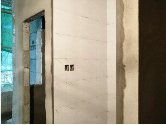
学生宿舍一组团 1#楼一层洗漱间墙面砖铺贴（3#楼同步） (2016. 5. 31)
