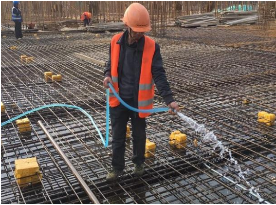
科五首层结构模板冲洗 (2017. 3. 15)
