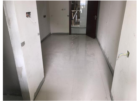
学生宿舍三组团 1-4#楼双人间地砖铺贴 (2017.3.13)
