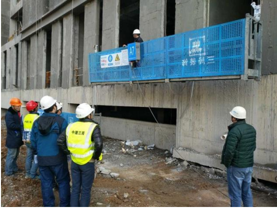
科教楼二北面吊篮验收 (2017. 3. 12)
