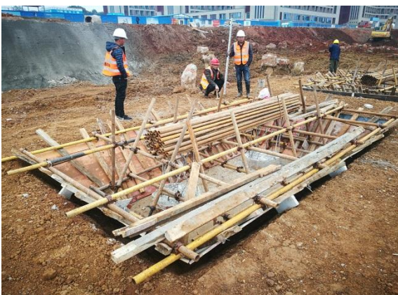
图书馆承台加腋施工 (2017.3.14)
