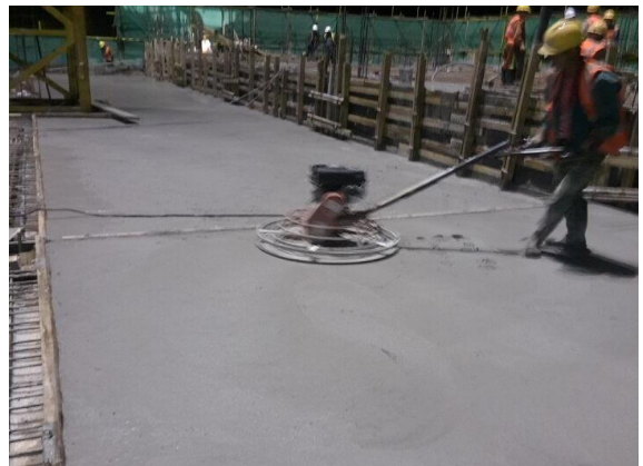
五标段 5-2#楼地下室顶板施工 (2017. 3. 15)
