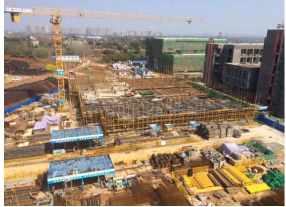
科教楼五施工全景 (2017. 03. 15)
