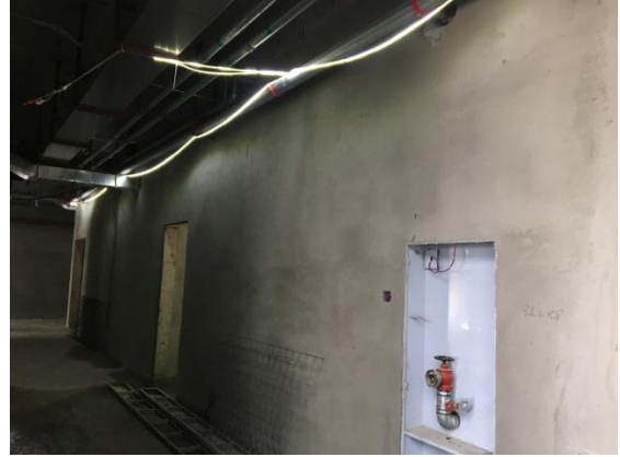
科教楼一抹灰施工 (2017. 3. 14)
