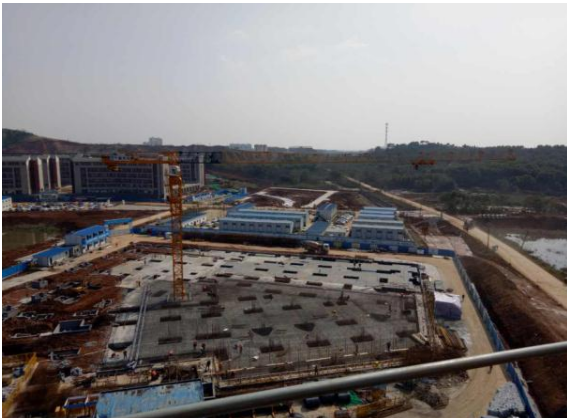
科教楼四施工全景 (2017. 03. 15)
