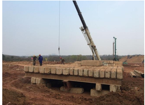
科教楼八桩基静载试验 (2017.3.10)
