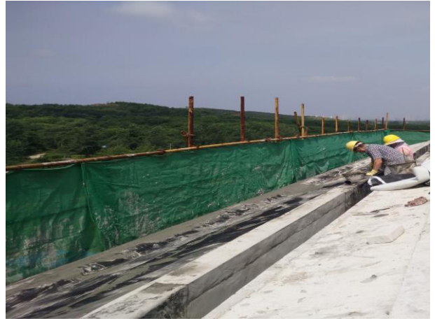
学一组团屋面天沟防水卷材施工 (2016.7.18)
