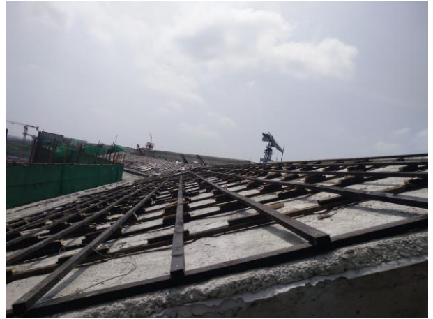
学一组团134号楼屋面顺水条安装 (2016.7.18)
