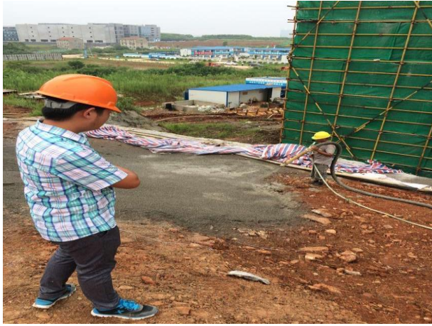
学一组团南侧边坡喷锚 (2016.7.15)
