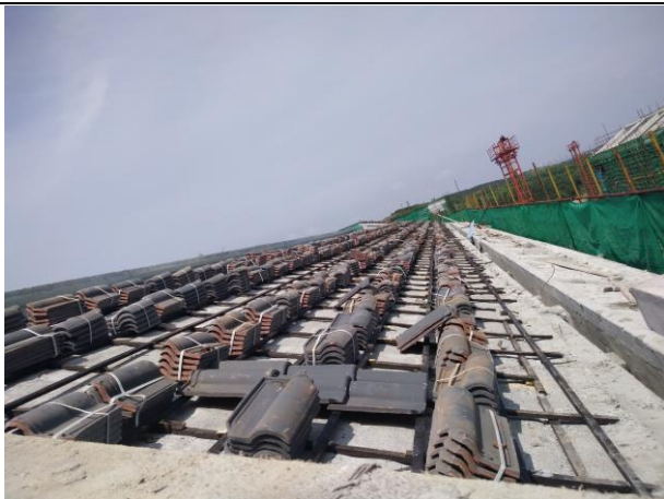
学一组团4号楼屋面陶土瓦施工准备 (2016.7.18)
