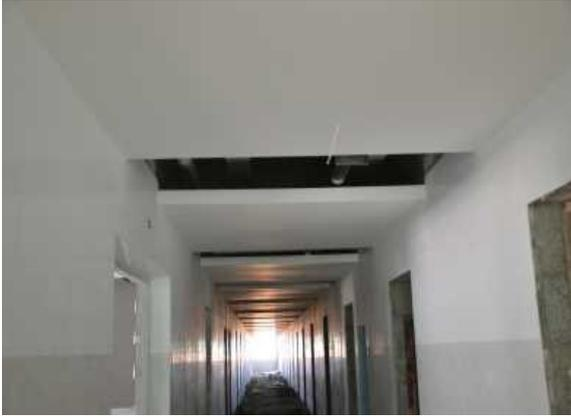
学生宿舍一组团 1\3\4 号楼一层走道石膏板吊顶施工
