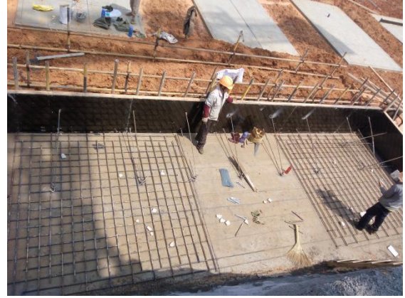
学生宿舍三组团 1#宿舍楼基础绑扎底筋 (2016. 6. 4)
