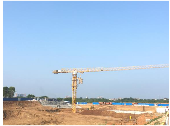
校前区科教楼一塔吊安装 (2016.5.30)
