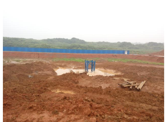
学生宿舍三组团 3#塔吊基础浇筑。 (2016.6.2)
