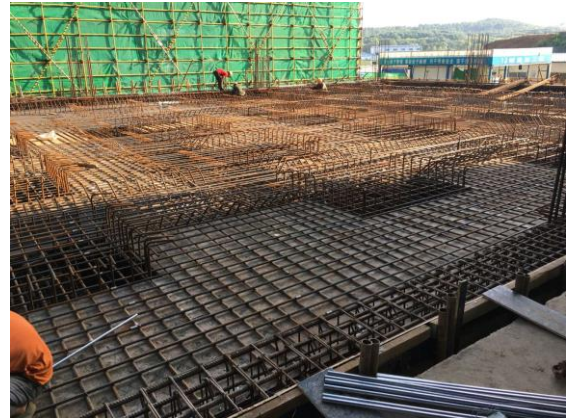
核心区科教楼二压机大厅施工 (2016.5.31)
