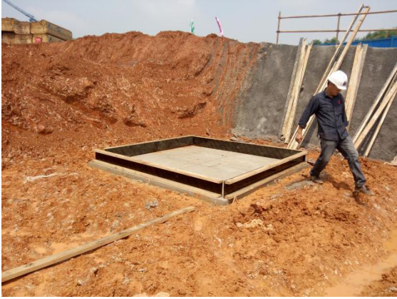
学生宿舍三组团 1#宿舍楼独立基础支模。 (2016. 6. 4)
