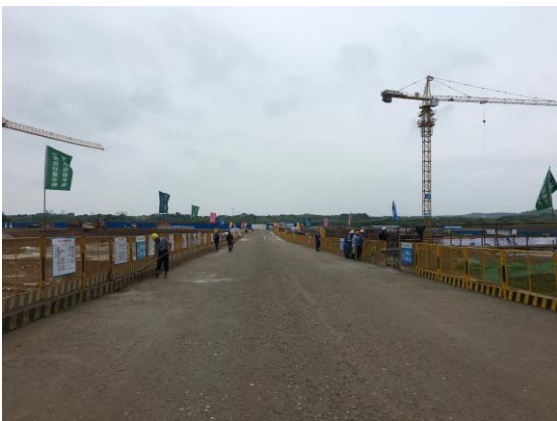
校前区、核心科教区现场安全文明施工 (2016.5.31)
