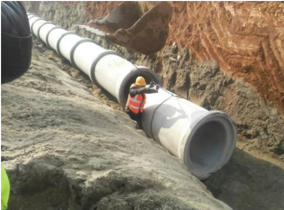
环一路 NY35-NY36 沟槽开挖及管道安装 (2017. 2. 28)
