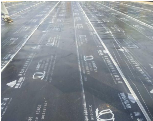
科教楼五底板防水铺贴 (2017. 3. 3)
