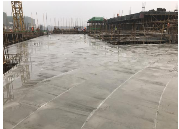
大学生活动中心 A-1 区一层竖向二层水平 梁板结构混凝土浇筑 (2017. 3. 6)
