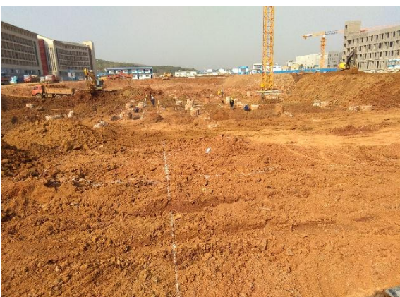
图书馆土方大面开挖 (2017. 3. 3)
