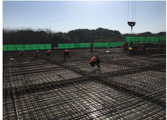
教工活动中心二层板钢筋绑扎 (2017. 3. 1)
