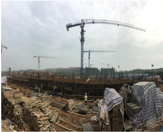
核心科教区项目科教二架空层模板支架施工 (2016.4.10)
