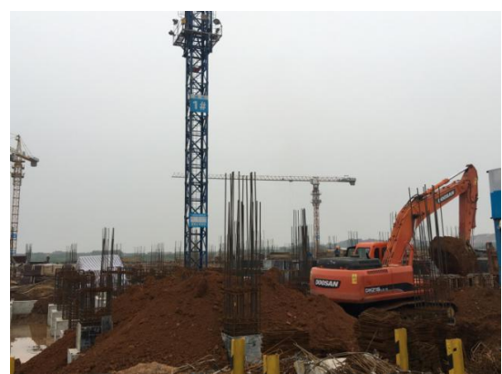
核心科教区项目科教二压机大厅土方回填 (2016.4.10)
