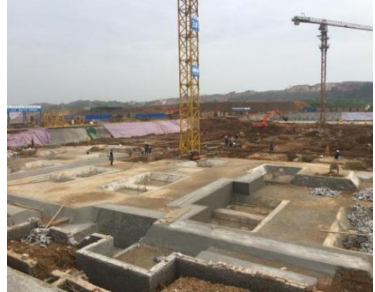
核心科教区项目公教二清底、准备浇筑垫层 (2016.4.10)
