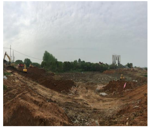
校前区项目教学服务中心清淤换填 (2016.4.10)
