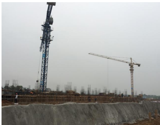
核心科教区项目科教二架空层架体施工 (2016.4.10)
