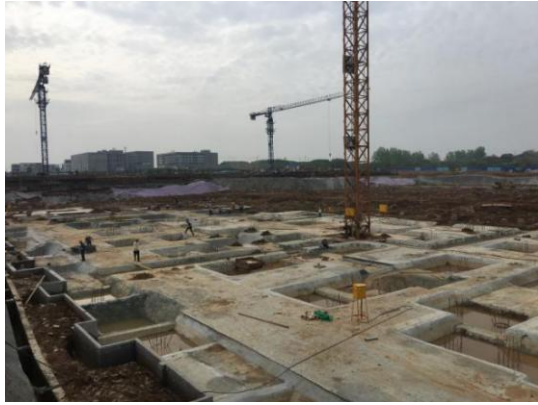
核心科教区项目公教一清底、准备浇筑垫层 (2016.4.10)
