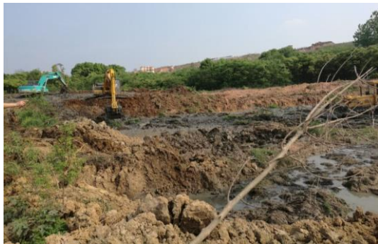
学生宿舍三组团建设项目泥浆开挖 (2016.4.12)
