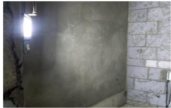
学生宿舍一组团项目 3#楼一层抹灰 (2016.4.13)
