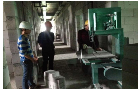
学生宿舍一组团项目砌体现场取样 (2016.4.15)
