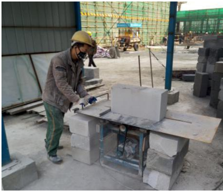
学生宿舍一组团项目砌块进行集中切割、配送 (2016.3.11)
