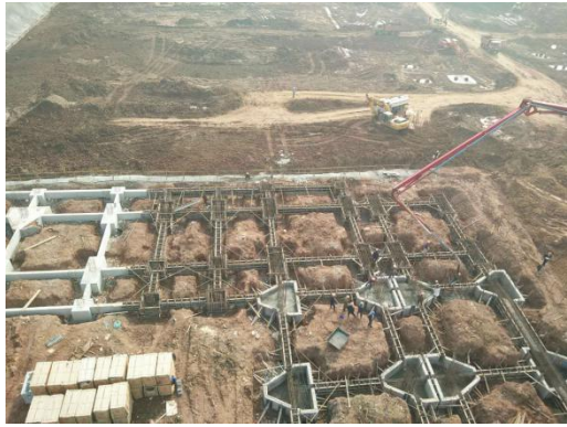
核心科教区项目承台浇筑施工 (2016.3.24)
