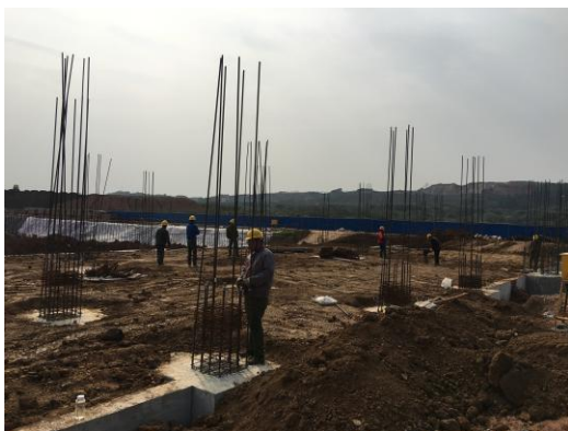
核心科教区项目国重区域土方回填 (2016.3.24)
