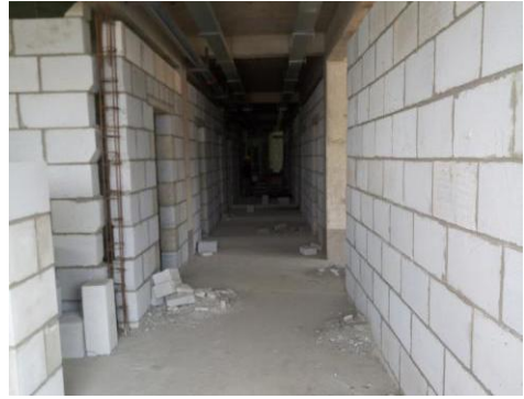
学生宿舍一组团项目砌体大面积施工 (2016.3.11)
