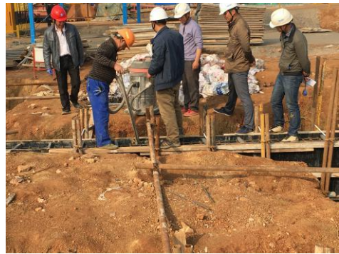
核心科教区项目地梁、承台模板内部清理 (2016.3.7)
