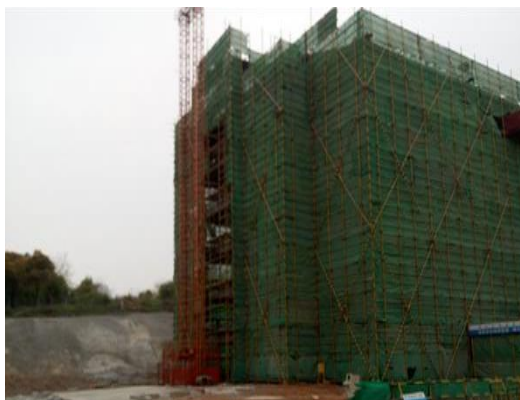
学生宿舍一组团项目 2#楼物料提升机搭设完成 (2016.3.26)
