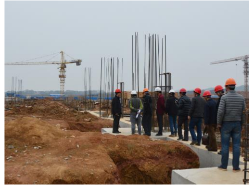
国重一、国重二桩基工程验收 (2016.3.15)
