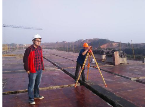
学生宿舍一组团项目 2#楼模板验收 (2016.3.7)
