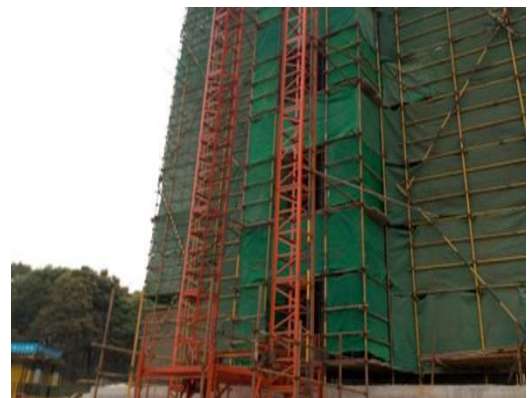
学生宿舍一组团项目 5#楼物料提升机搭设完成 (2016.3.26)
