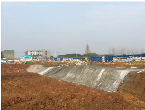
核心科教区项目公共教学楼区域喷锚 (2016.3.11)
