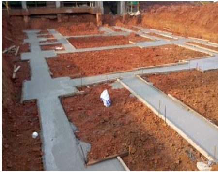
学生宿舍一组团项目 1#楼附属楼基础垫层完成 (2016.3.16)
