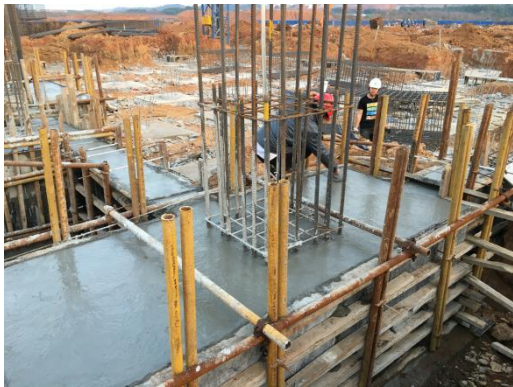
核心科教区项目基础承台混凝土收光压面 (2016.3.7)
