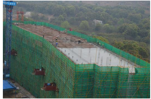
学生宿舍一组团 5#楼封顶 (2016.3.23)
