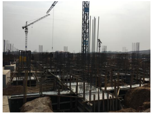
核心科教区项目科教楼区域混凝土浇筑 (2016.3.24)
