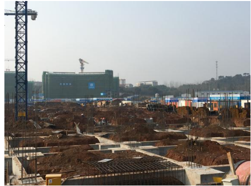
核心科教区项目科教区承台垫层浇筑 (2016.3.11)
