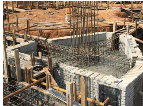
核心科教区项目承台混凝土分层浇筑 (2016.3.7)
