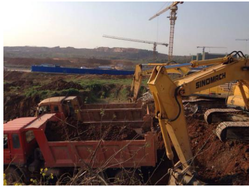
校前区土方开挖 (2016.3.25)
