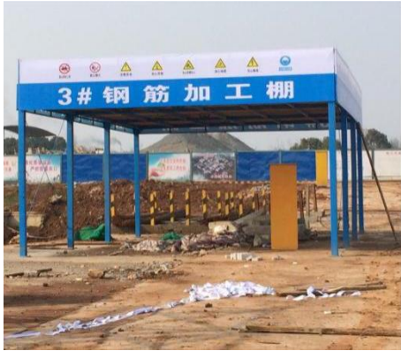
核心科教区项目 3#、4#钢筋加工棚安装及 CI 制作 (2016.3.10)
