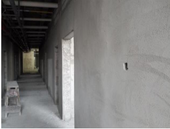
学生宿舍一组团项目地下室砌体抹灰 (2016.3.22)
