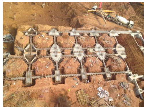
核心科教区项目承台、地梁浇筑施工 (2016.3.24)
