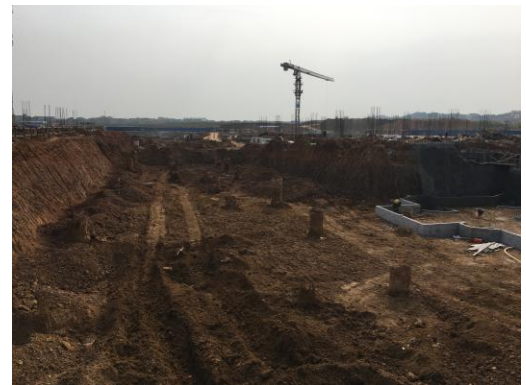
核心科教区项目国重区域小地下室土方开挖 (2016.3.24)
