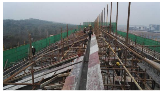
学生宿舍一组团项目 2#楼斜屋面模板施工 (2016.3.18)
