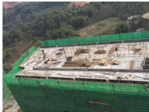
学生宿舍一组团 2#楼封顶 (2016.3.12)
