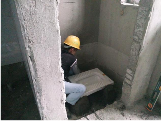
学生宿舍一组团1#楼一层蹲便器安装 (2016.6.5)
