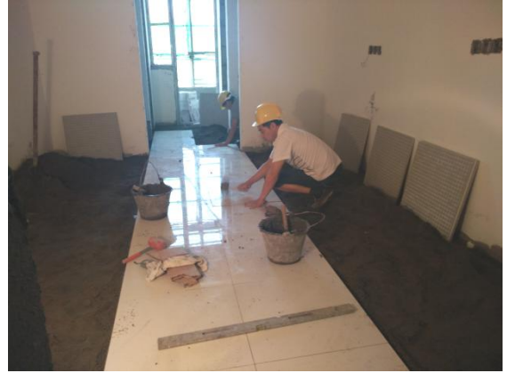
学生宿舍一组团1号楼地砖铺施工中 (2016.6.6)
