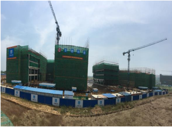
校前区、核心科教区施工现场全貌 (2016.6.5)
