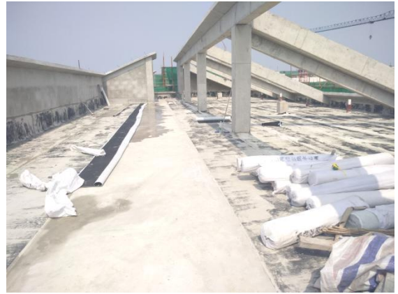
学生宿舍一组团1号楼屋面第一道防水卷材施工中 (2016.6.5)
