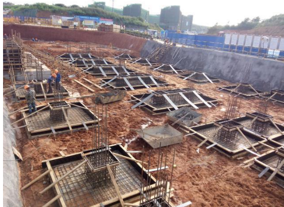
学生宿舍三组团 1#宿舍楼承台钢筋绑扎。 (2016. 6. 6)
