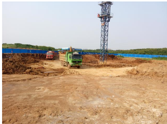
学生宿舍三组团 2#宿舍楼土方开挖。 (2016. 6. 6)
