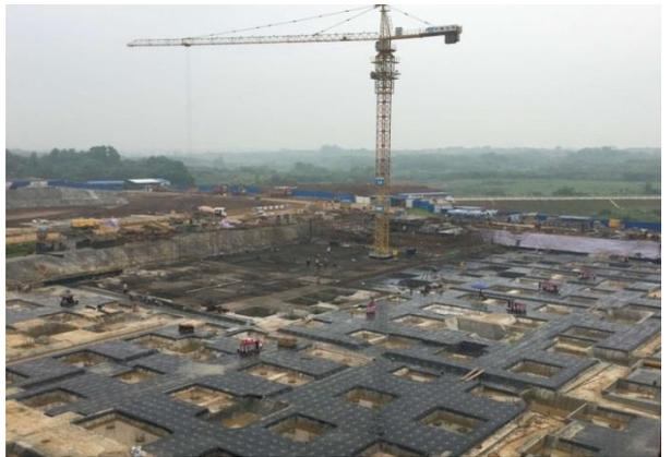
公教一底板施工、地下室结构施工
