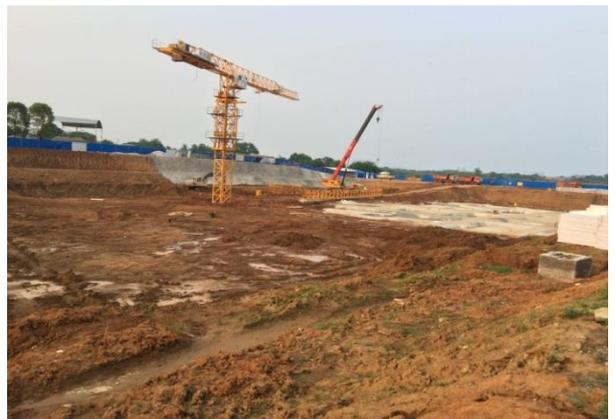
科教楼一基础垫层施工、塔吊安装
