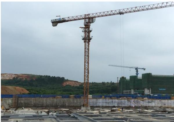
公教二底板施工、地下室结构施工
