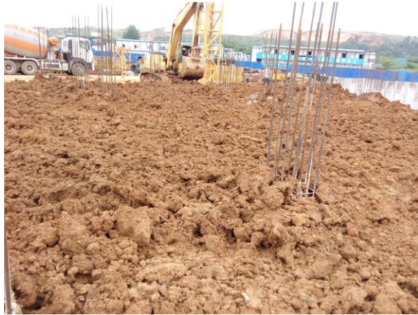
学三组团 1#宿舍楼土方回填。 (2016.7.11)
