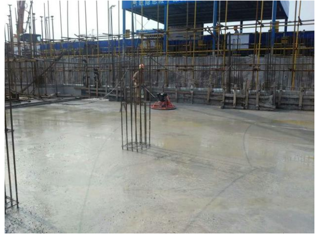
学三组团 2#宿舍楼底板混凝土浇筑（F3区）。 (2016.7.11)
