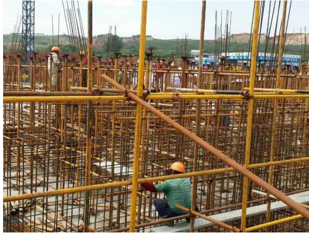
学三组团 2#宿舍楼满堂架搭设（F1区）。 (2016.7.8)
