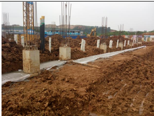
学三组团 1#宿舍楼砖胎膜施工。 (2016.7.17)
