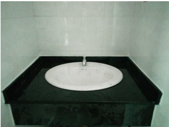
学生宿舍一组团洗漱间台面及台盆安装样板 (2016.7.28)
