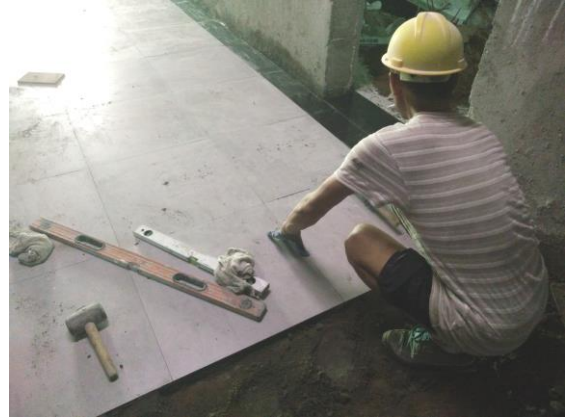
学生宿舍一组团走道地砖铺贴 (2016.7.24)
