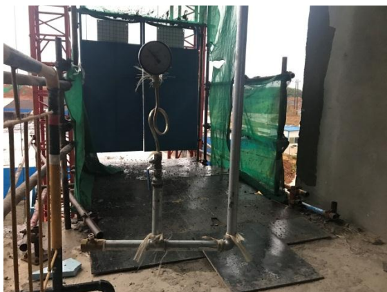
科教楼二喷淋系统试压 (2017. 2. 21)
