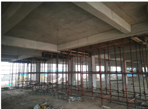
能源中心顶板拆模后效果 (2017. 2. 21)
