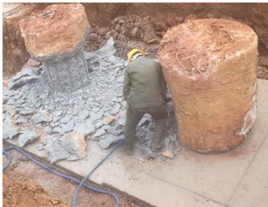
科教楼四桩头破除 (2017. 02. 19)
