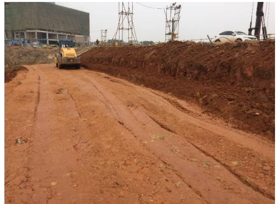
环一路地大湖外侧路基筑填 (2017. 2. 20)
