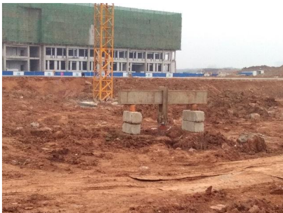
图书馆项目工程桩抗拔检测 (2017. 2. 20)
