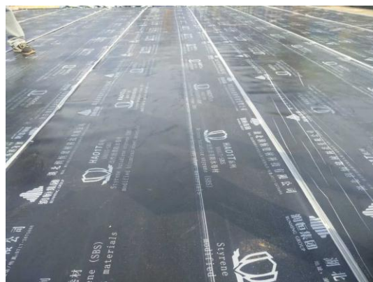
科教楼五防水卷材铺贴施工 (2017. 02. 21)
