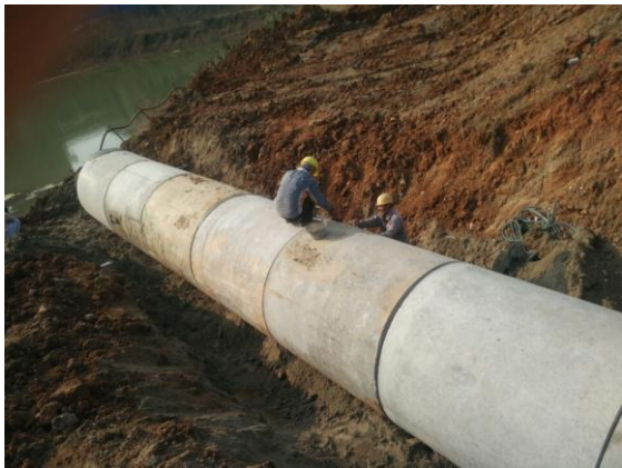
环一路地大湖溢水口过路管施工 (2017. 2. 17)
